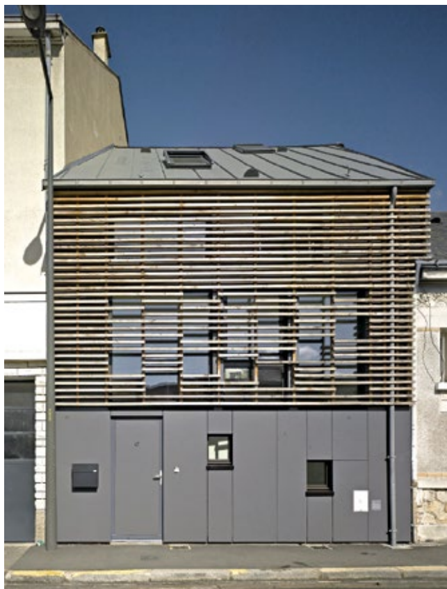
Construction d'une maison à ossature bois en centre-ville (en secteur sauvegardé et en zone inondable)
